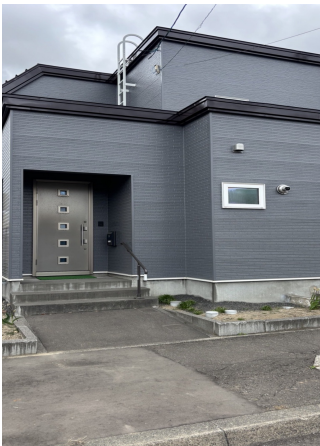
実施工写真 / 札幌市北区 外壁屋根塗装 Y様邸
